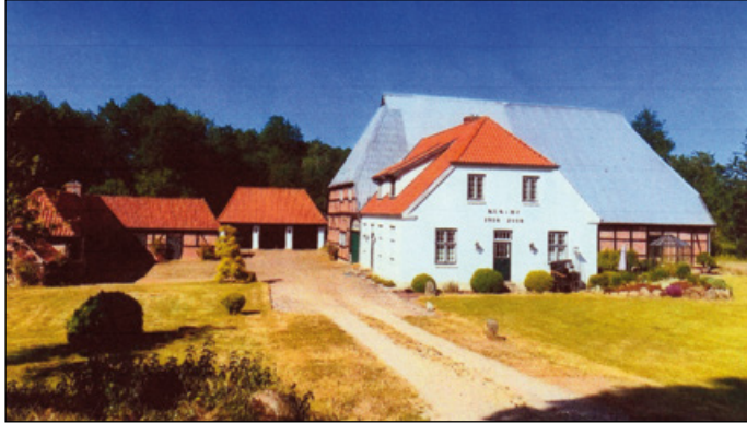
Gebäudeensemble des Mühlenhofes der Rantzauer Papiermühle im Jahre 2023 (links im Bild der Kleintierstall, der aus der Gegenrichtung gesehen auf der Skizze von Schilling zu sehen ist (s. Abb.1).
