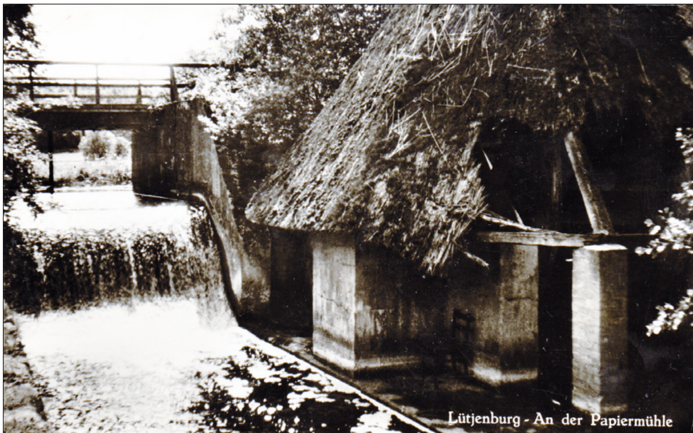
Das Mühlenwehr vom Mühlengraben aus gesehen (1956). Rechts im Bild sind die Fundamente für das Wasserrad zu sehen. Darüber befand sich ein Dach mit Reetdeckung.
