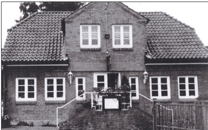
Kurze Twiete Nr. 4 nach der Instandsetzung (1979); Nutzung zunächst als Parfümerie, dann als Gaststätte „Gutgesell“ 1983; anschließend Übernahme als Gasthaus „Zur Twiete“ durch Frau Gabriela Grütze, schließlich mit Torsten Friedrichsen als Pächter.
