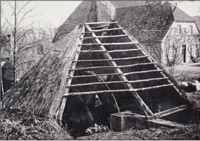
Blick auf die mit Reet gedeckte Überdachung des Wasserrades (im Hintergrund die Barockscheune).
